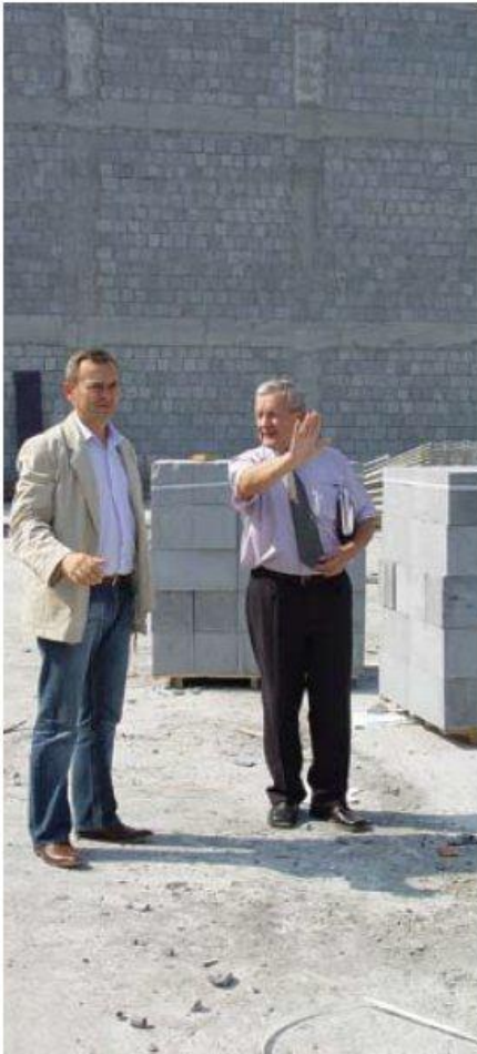
Starosta Leżajski Robert Żołynia i Dyrektor ZSL Stanisław Bartnik nadzorują postęp prac budowlanych hali sportowej fot. Damian Majkut (2)
